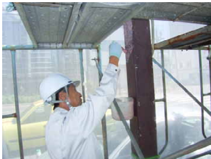
写真4：インバイロワンを規定量塗布
