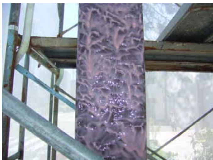
写真5：塗布後の状態
