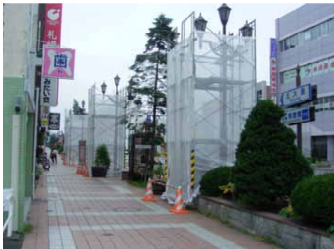
写真3：仮設足場設置状況
