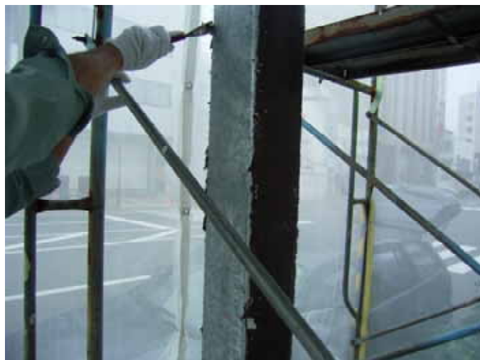
写真 8 : 既存塗膜が簡単に除去できる
