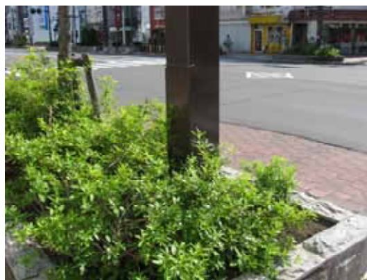
写真 2：植樹帯に設置されている照明柱
